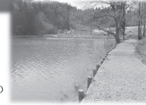
遊歩道の設置 (1.6km)
